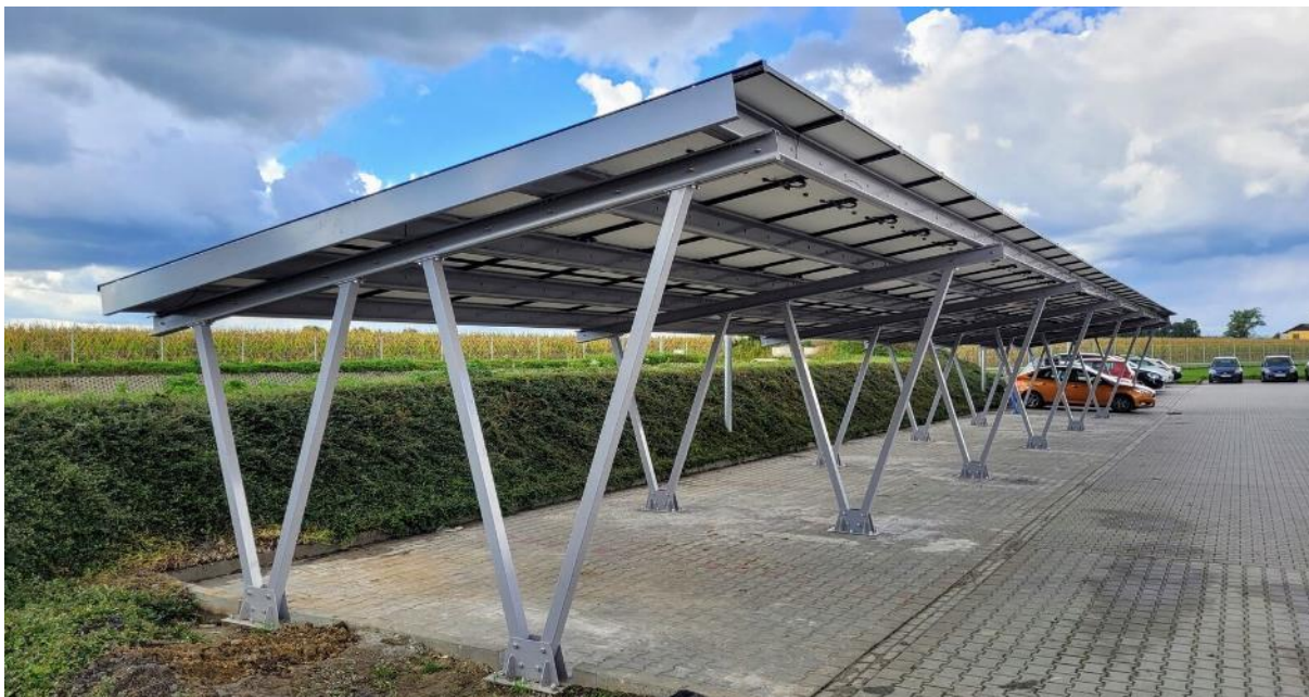
Abbildung 25: PV-Überdachung für mehrere Stellplätze
