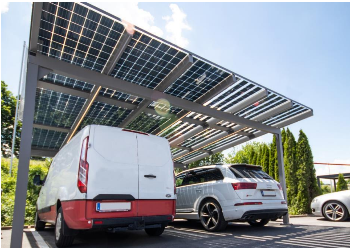
Abbildung 26: PV-Überdachung für zwei Stellplätze
